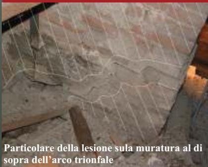
Particolare della lesione sulla muratura al di sopra dell'arco trionfale
