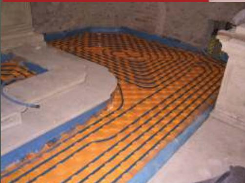
Posa dell'impianto di riscaldamento a pavimento.
