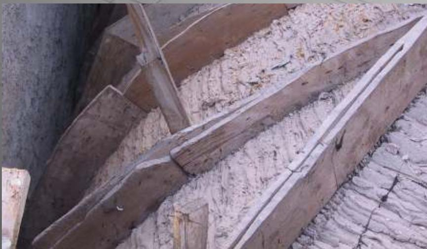
Particolare della struttura del controsoffitto a volta in legno.
